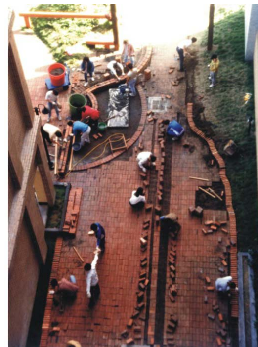
圖3 新科館庭園施作
